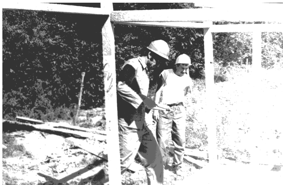
Строительство объекта «первой категории» (туалет)
