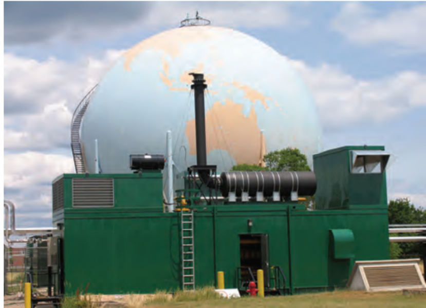
Рис.3.3 – Біогазова когенеративна установка фірми Hamilton Renewable Power (США)
