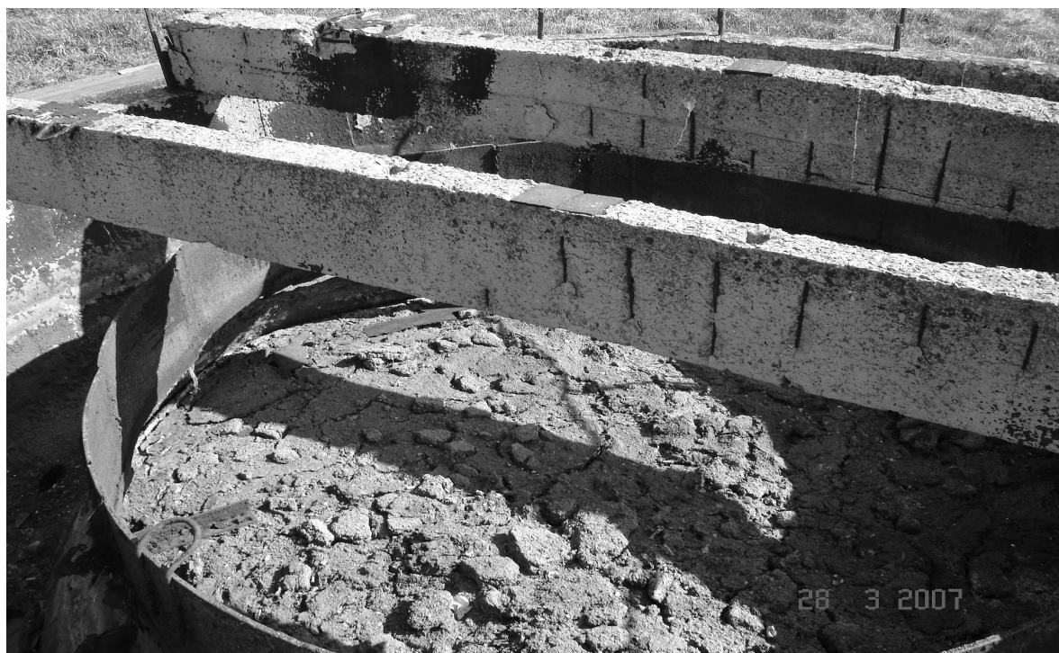
Фото 3 – Вертикальна пісколовка другої технологічної лінії 1 а (вид зверху)
