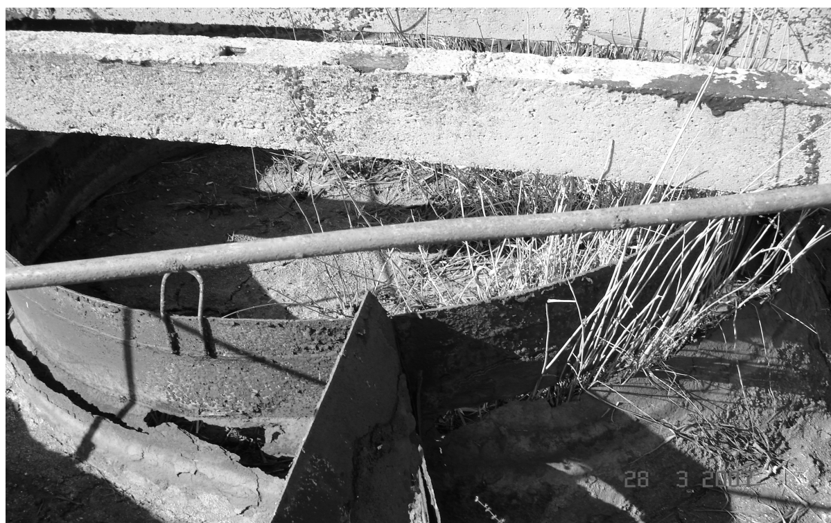
Фото 2 – Вертикальна пісколовка другої технологічної лінії 1 а (вид збоку)
