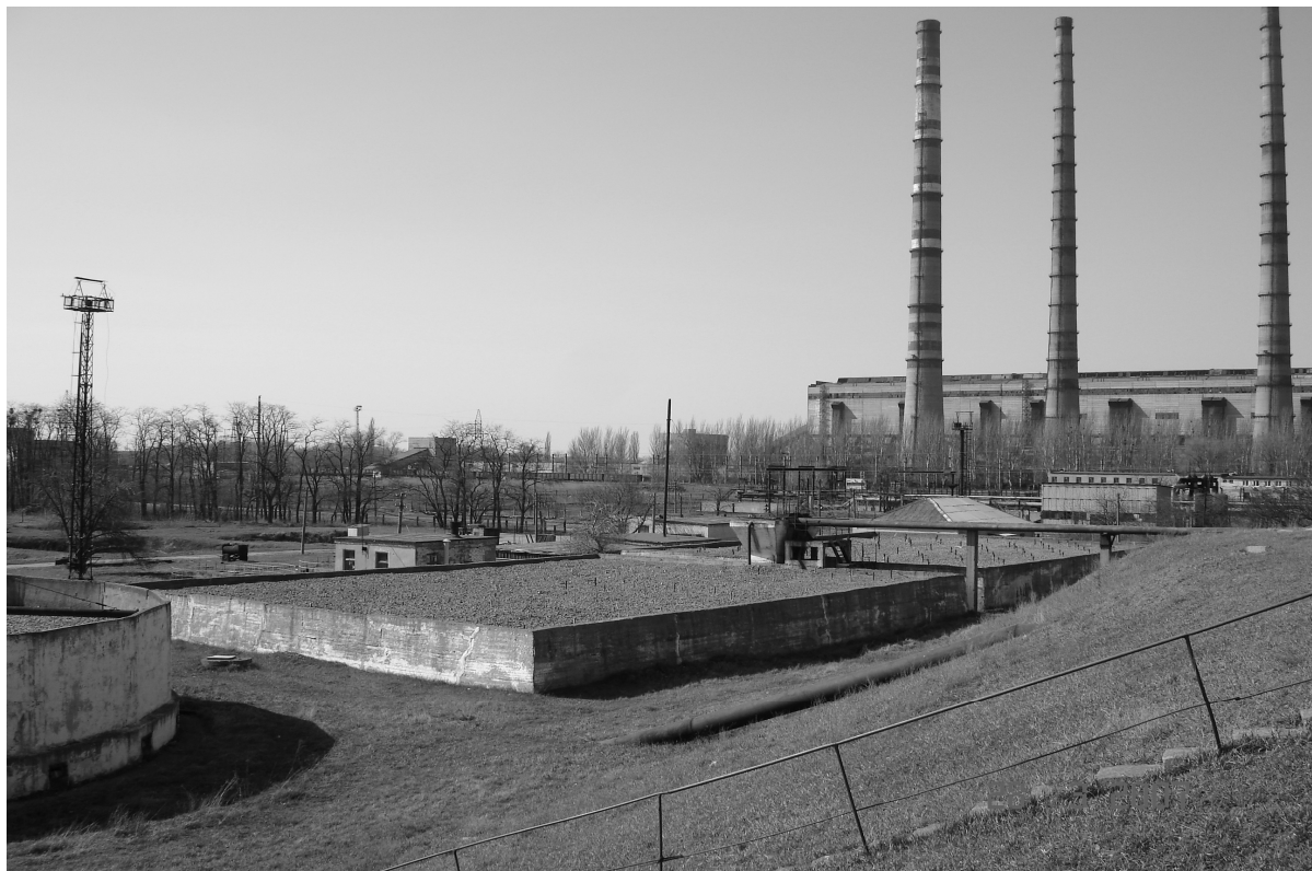
Фото 1 – Біофільтри першої технологічної лінії
