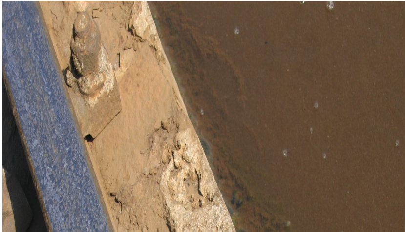
Рис. 5.3. Біообростання стінок вторинного відстійника
