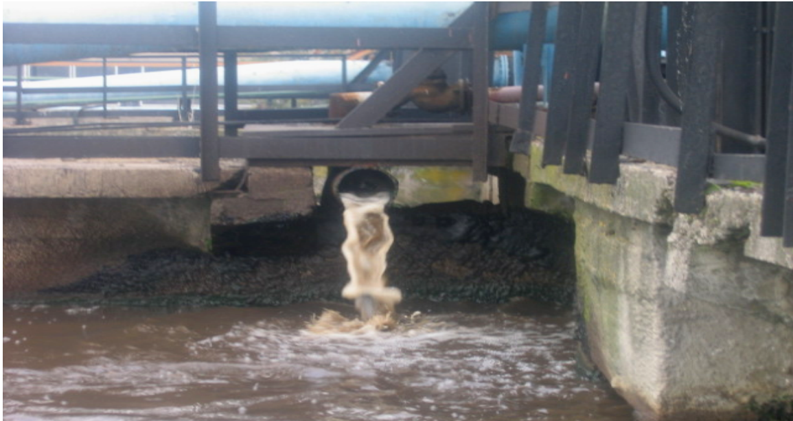
Рис. 5.22. Загальний вигляд внутрішньої циркуляції активного мулу ерліфтом
