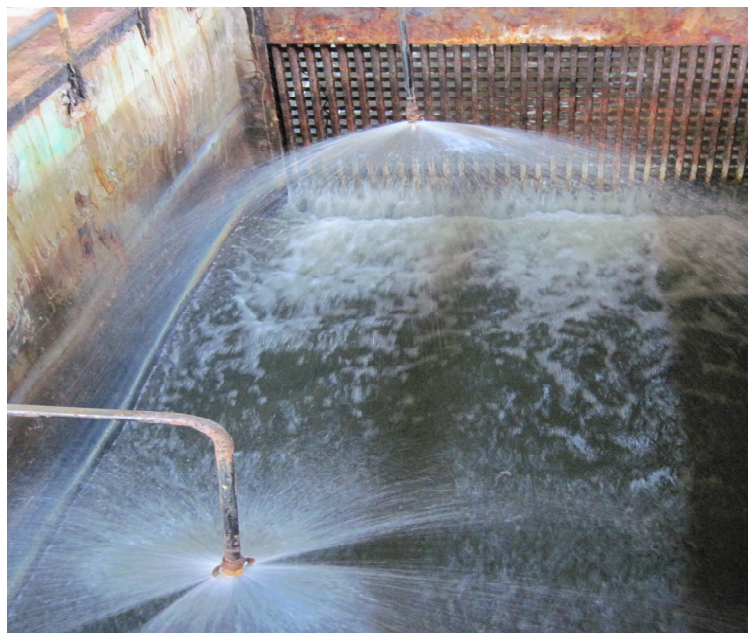
Рис. 3.1. Змішувачі дірчастого типу
