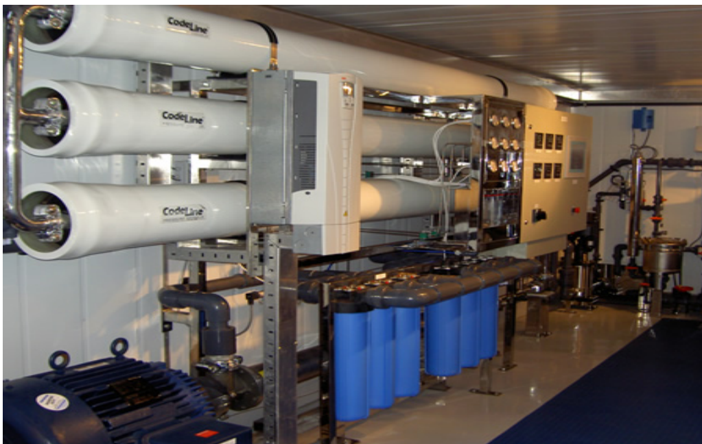
Рис. 4.10. Установка очищення води зворотним осмосом в контейнерному виконанні
