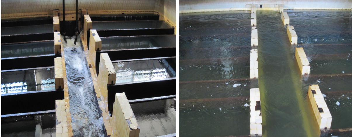
Рис. 3.11. Заповнення фільтрів водою для фільтрації
