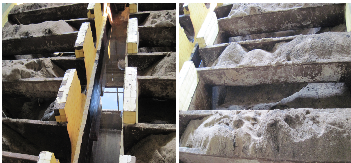
Рис. 3.8. Завантаження фільтрів
