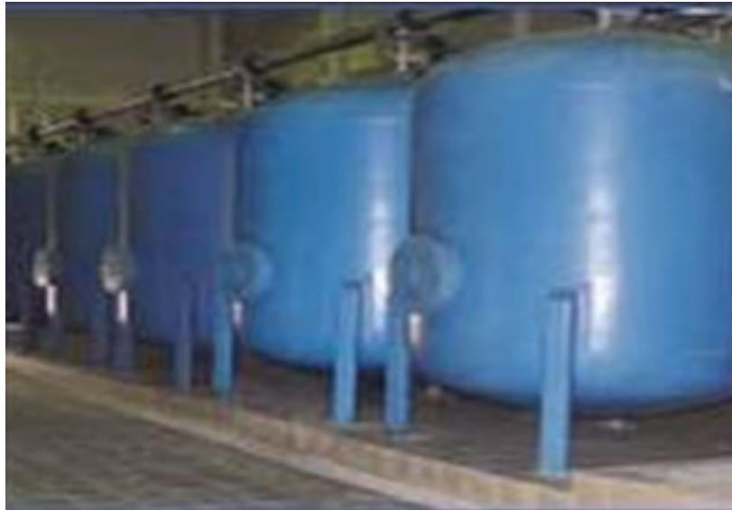
Рис. 4.4. Блок напірних засипних фільтрів
