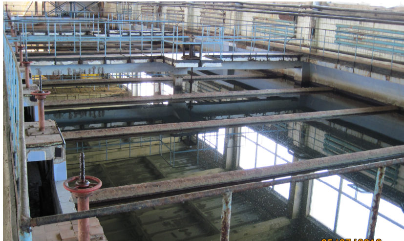
Рис. 3.6. Горизонтальні відстійники
