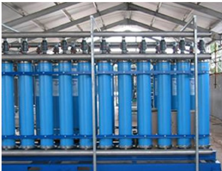
Рис. 4.5. Блок напорної ультрафільтрації
