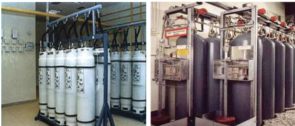
Рис. 7.11. Автоматична установка газового пожежогасіння
