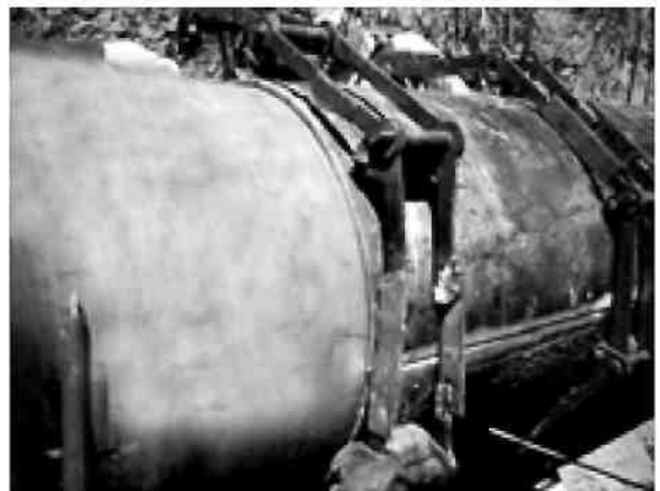
Рисунок 45 – Упровадження ремонтних технологій на об'єктах «Укртрансгазу»: а — двошарова муфта; б — врізка відводу в газопровід під тиском; в — компанундна муфта
